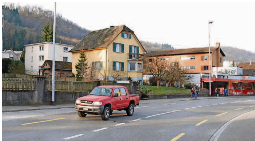
Bruggerstrasse: Hier sollen drei neue Gebäude gebaut werden, in denen Gewerbe und Wohnungen untergebracht sind. ELJ
